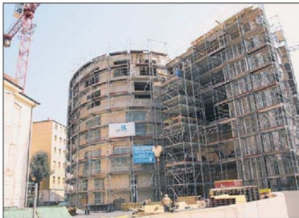
Arbeiten auf Hochtouren: Der Rohbau des Christlichen Kinderhospitals am Marienhospital ist fast fertig. PR-Foto
